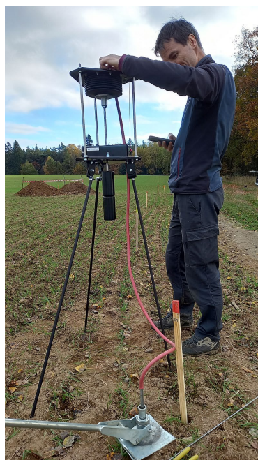
Obrázek 4 Měření plynopropustnosti zemin pomocí měřicího přístroje RADON-JOK
